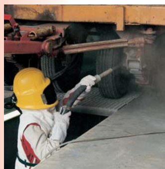
Otryskávanie podvozkov kamiónov Truck sandblasting
