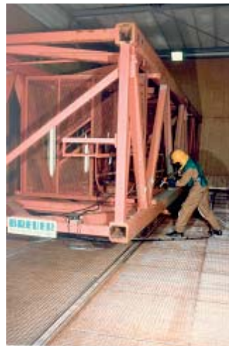
Oceľové konštrukcie Steel construction
