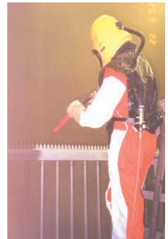
Otryskávanie plotov a mreží Grid sandblasting
