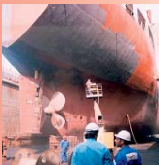
Schiffssanierung Ship renovation
