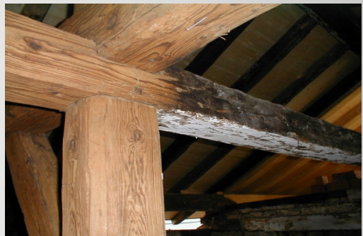
Strešné trámy: odstránenie nečistôt a náterov
