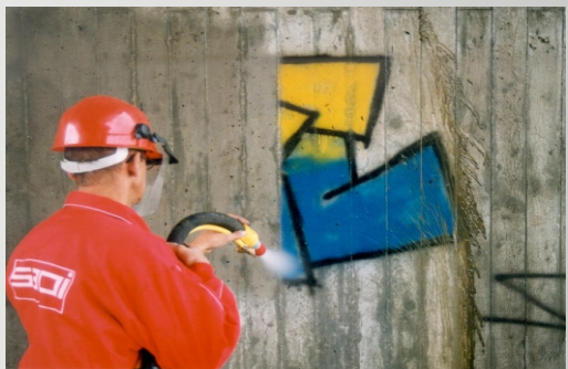
Odstraňovanie graffiti bez poškodenia povrchu
