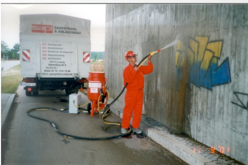
Odstraňovanie graffiti bez poškodenia povrchu
